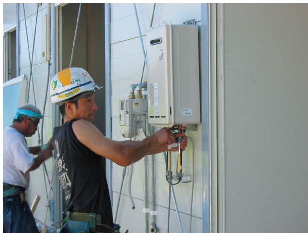
仮設住宅に設置している様子
