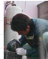
地震発生後、戸建住宅でガス漏れの有無を点検している事業者
